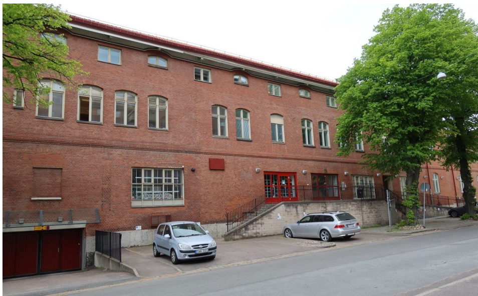
Figur 18: Del av fabriksbyggnad 1: a, vy från Svangatan.
