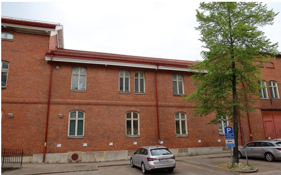
Figur 20: Del av fabriksbyggnad 1: a, vy från Svangatan.
