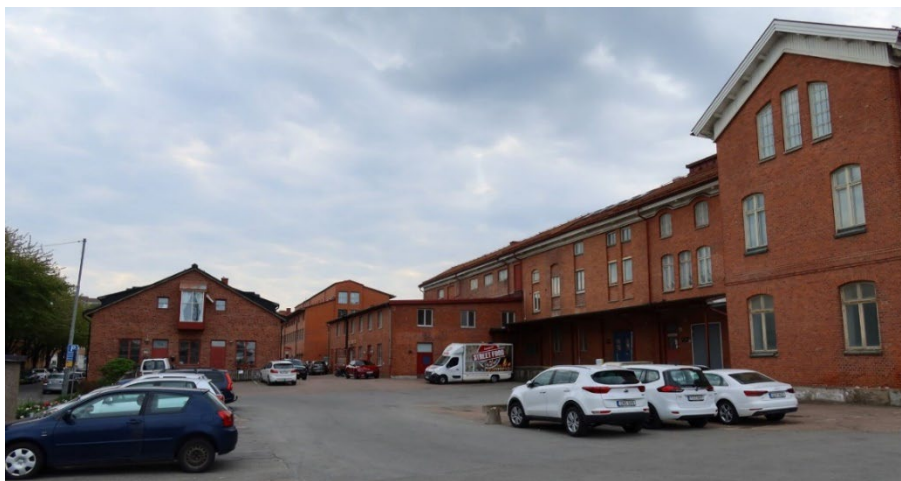
Figur 19: Del av fabriksbyggnad 1: a, mot gård, vy från nordväst.
