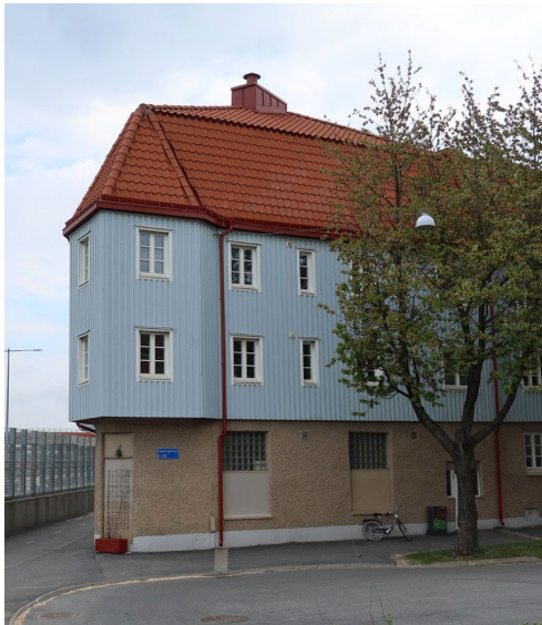
Figur 28: Landshövdingehus i kvarteret Zebran vid Ejdergatan norr om planområdet.
